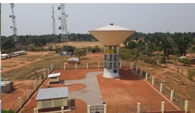
Travaux des espaces à vivre et Forage
